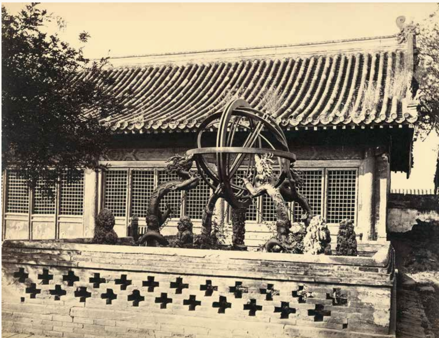
Peking 331. Astronomisches Observatorium / (von dem Jesuiten im vorigen Jahrhundert). Čína, Peking, armilární sféra zdobená čtveřicí bronzových draků, součást rozsáhlé observatoře, přístroj byl používán pro měření poloh hvězd a planet a určování času, z cesty z let 1872–73, 209 × 272 mm, fotograf neveden. Album IV, karton 331.
